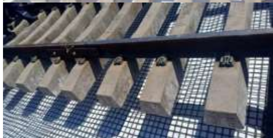
Процесс укладки геотекстиля и плоской георешетки
