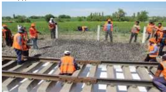
Процесс срезки балласта под шпалами, формирование ровной поверхности основной площадки
