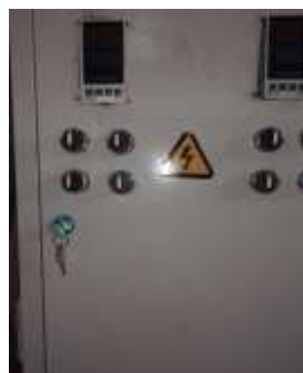
Рис. 6. Шит автомат для регулирования температуры жидкости в реакторе
