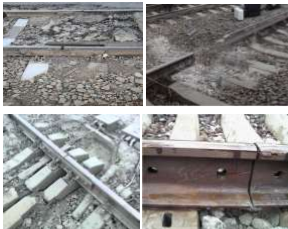
1-rasm. Relslar biriktirilgan hududdagi nosozliklar
