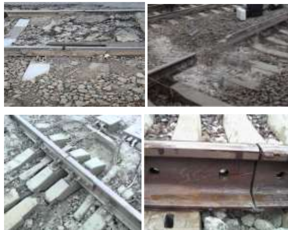
1-rasm. Relslar biriktirilgan hududdagi nosozliklar
