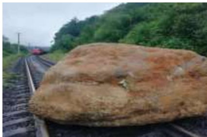
5-rasm. Temir yo'l izini tog' toshlari bosib qolishi
