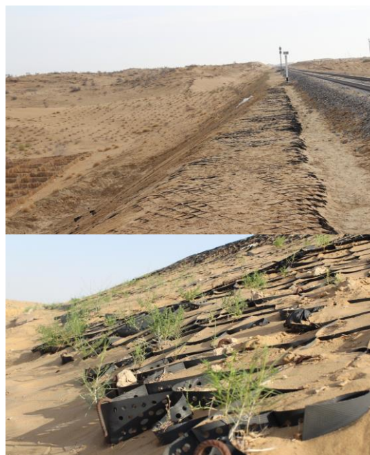
Рис. 2. Процесс заполнения ячеек георешеток уложенных на откосы местным грунтом и посев семян пескостойких трав
