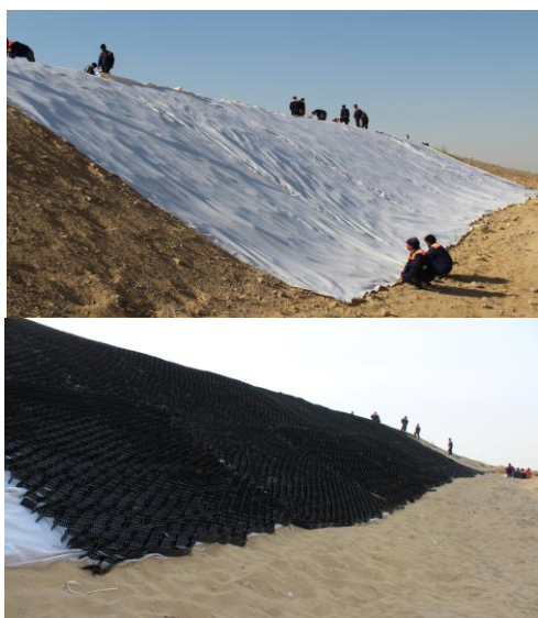
Рис. 1. Процесс укладки геосинтетических материалов на откос земляного полотна
