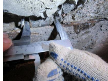
2-rasm. Yig'ma temir-beton qoplama choklarining ochilish kattaligini o'lchash
