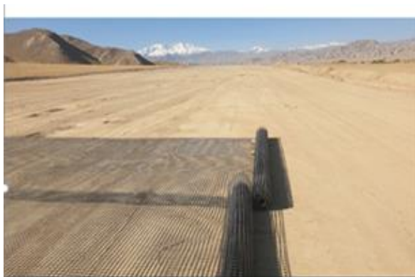
7-rasm. Xitoy-Qirg'iziston-O'zbekiston temir yo'l trassasi qurilishida Qirg'izistonda o'tuvchi temir yo'l asosini va poyini qatlamlab zichlashda jarayonidan lavha
