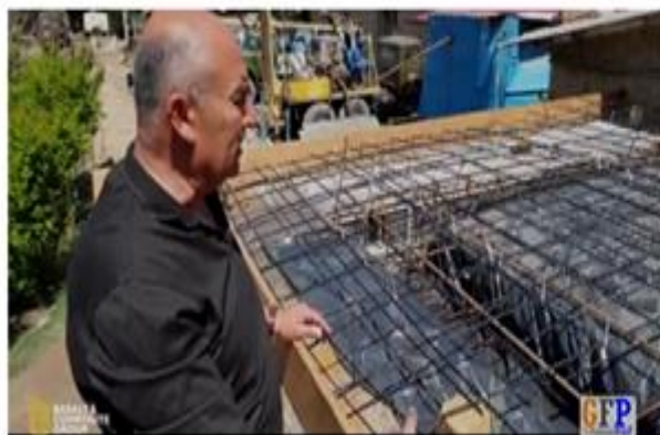
4-rasm. Bino ora yopmasini barpo etish jarayonidan lavha
