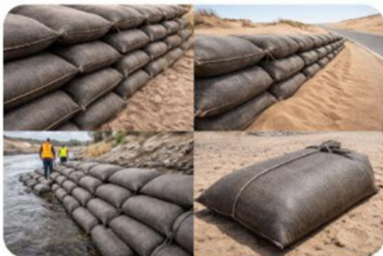
10-rasm. Bazalt tolalaridan eshilgan iplardan tayyorlangan qoplardan avtomobil va temir yo'llarini ko'chuvchi qumlardan himoyalash uchun to'siqlar va daryo o'zanlarini mustahkamlash jarayonidan lavhalar [7]
