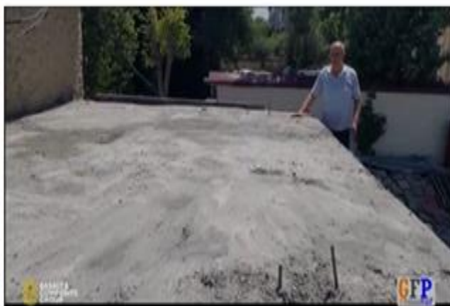
5-rasm. Bino ora yopmasi betonlangandan keyingi lavha
