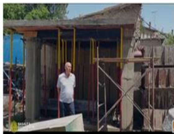
5-rasm. Bino ora yopmasi betonlangandan keyingi lavha
