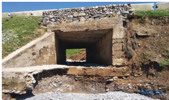
1-rasm. Daryo qirg'oqlaridagi inshootlar poydevori asoslarini sel yuvish hollari [6]
