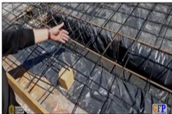
4-rasm. Bino ora yopmasini barpo etish jarayonidan lavha
