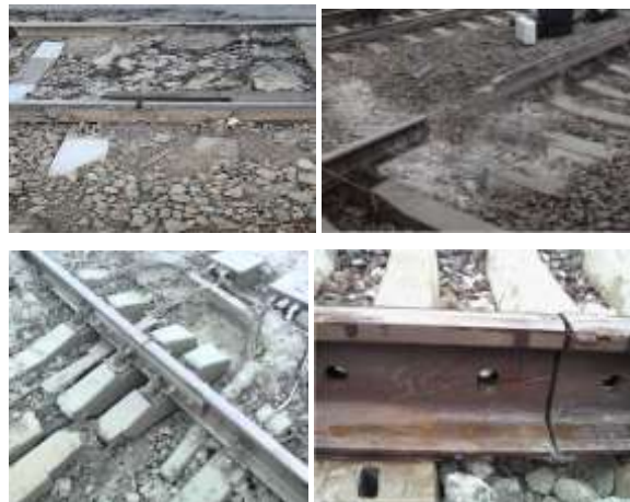
1-rasm. Relslar biriktirilgan hududdagi nosozliklar
