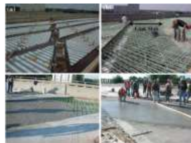
4-rasm. 2005-yilda AQSHning Michigan shtatining janubi-sharqida amalga oshirilgan ECC-betondan ko'priki qoplamasi loyihasi[5]
