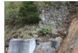
6-rasm. Turg'un bo'lmagan blokni yuqori mustahkamlikka ega to'r yordamida anker bilan mahkamlash
