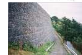
7-rasm. Gabionlardan hosil qilingan himoya inshooti. a) inshoot sxemasi; b) umumiy ko'rinishi
