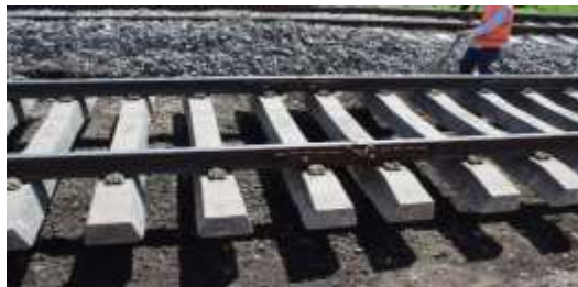
Процесс срезки балласта под шпалами, формирование ровной поверхности основной площадки
