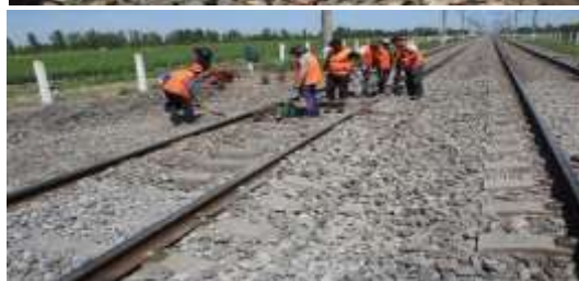
Процесс засыпка Выправка пути с помощью ЭШП используя домкраты для подъёмки рельсовых нитей
